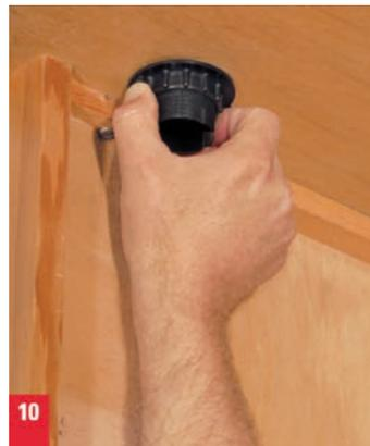
10. Rändelmutter von unten auf die Dachdurchführung schrauben.
