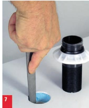
7. Loch ausfeilen. Dachdurchführung einsetzen.
